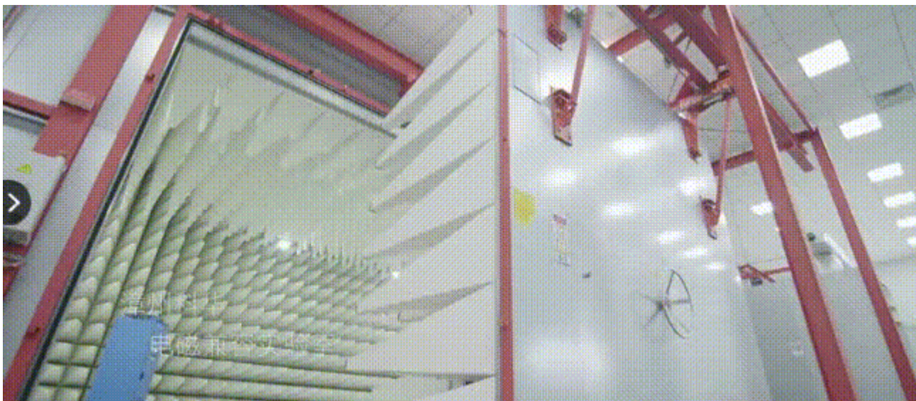
EMC центр тестирования
