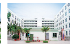
Завод в г.Сямынь
