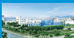
Завод в г.Жангжоу
